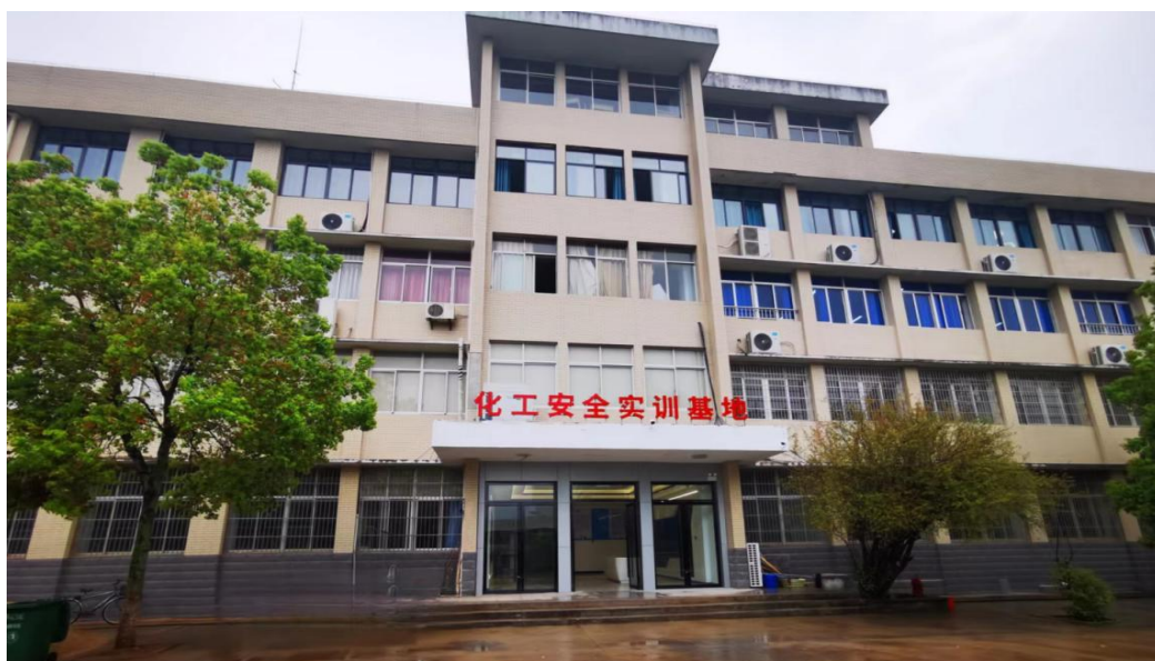
图4-12 我校化工安全实训基地
