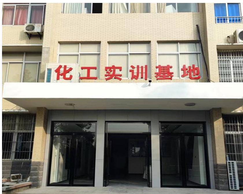
图7-56 化工实训基地实景图
