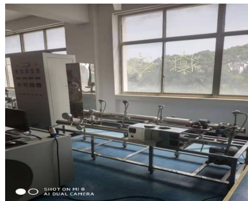
图2-38 仪表自动化实训室
